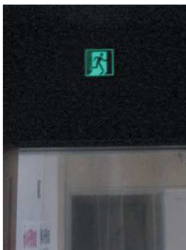
非常口ドア上部
