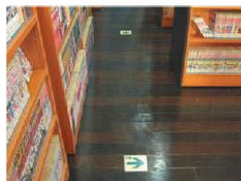
店舗床塩ビタイルの施工例
