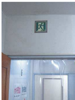
非常口ドア上部
